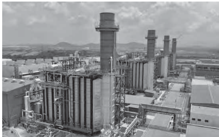
ガルフ・エネルギー向けに2021年3月に竣工した 初号機
